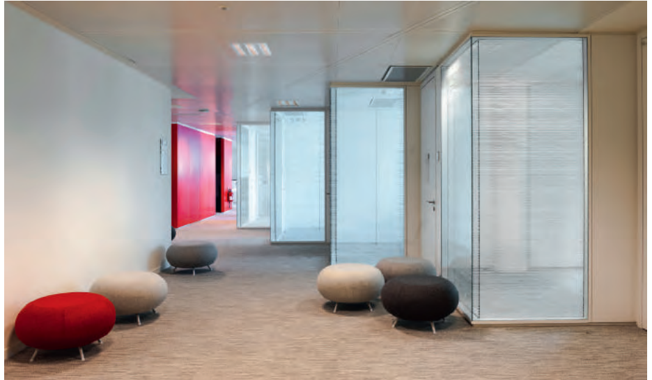
Trennwand: Metropolines 2. Decke: Metalldecke mit Langfeldplatten.
