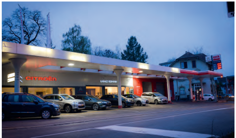
Bis Ende 2017 ist die Garage Rebmann AG noch an der Buchserstrasse 66 in Aarau – danach wird sie neu im nahen Quartier «Torfeld Süd» domiziliert sein.
