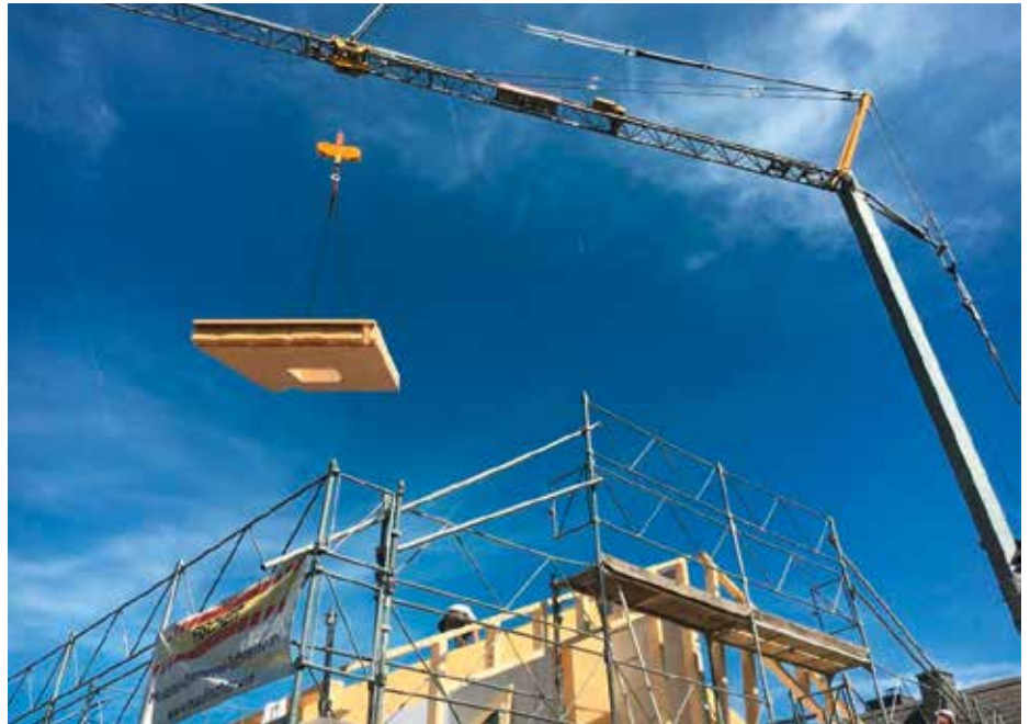
Element-Holzbau: Aufrichten eines Hauses in Aarau
