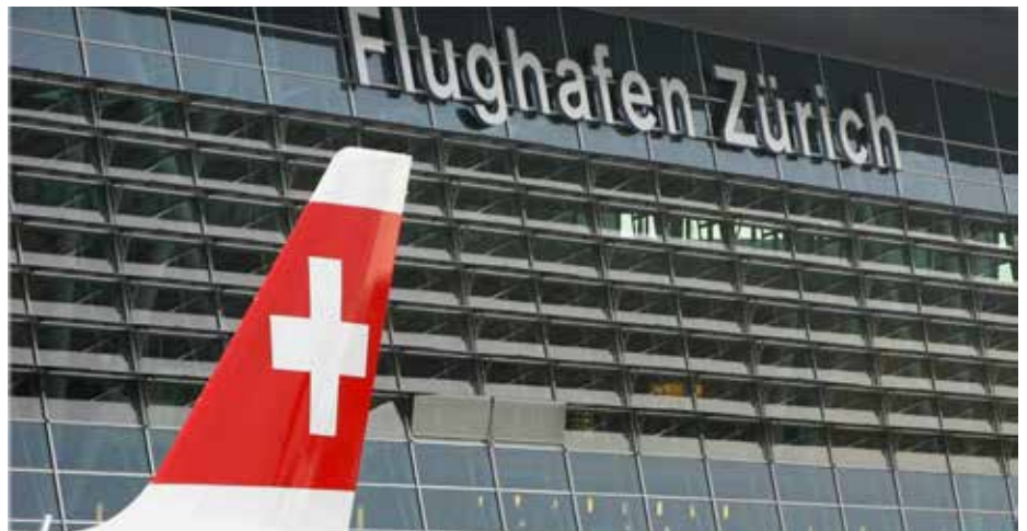
Das innovative Fiber-Flow-System der stäger-comdist kam auch am Flughafen Zürich zum Zug.
