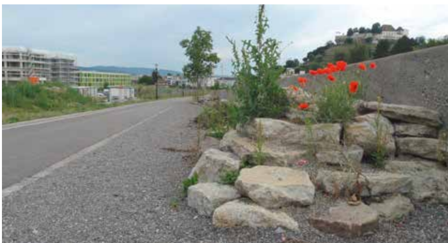
Bild inkl. Lokalkolorit: Eine über 300 Meter lange Stamfbetonmauer von Max Fischer umgibt das Baufeld Widmi – vor dem malerischen Hintergrund des Schlosses Lenzburg.
