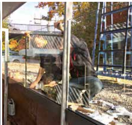
Chefmonteur Hendrik Sauer montiert mit einem Mitarbeiter ein Glasgeländer.
