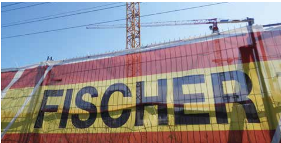
Aktuelle Grossbaustelle «Lindenblick» in Staufen
