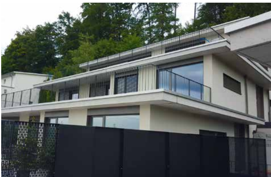
Anschauliches Beispiel: Überbauung mit Metallbauarbeiten aus dem Hause LUN in Stetten.
