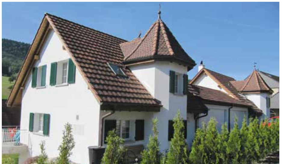
Schönes Beispiel: Zwei Einfamilienhäuser in Nunningen mit Dachkonstruktion und Eindeckung der Hans Blattner AG.
