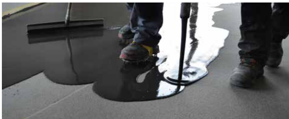
Mineralischer Spachtel-Designboden wird auf Zementuntergrund gegossen.
