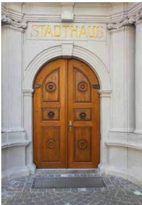
Wertige Flügeltür bei einem Stadthaus
