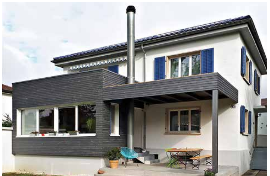
Umbau Schuler, Aarau: Anbau Sitzplatzüberdachung und Fassadenverkleidung
