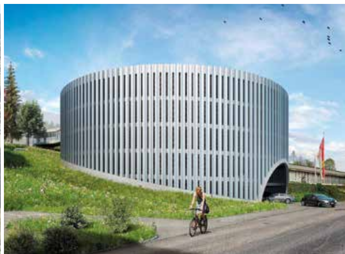
Das markante, aus Sichtbeton gefertigte Parkhaus bildet die Verbindung zwischen der «Oberstadt» und den tiefer liegenden Gebieten um den Bahnhof.
