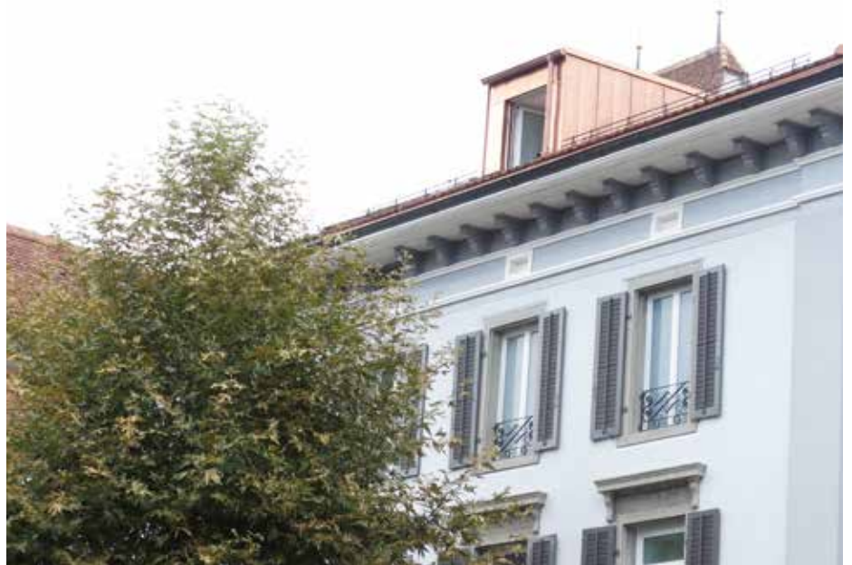
Altstadthaus Lenzburg: Komplettsanierung mit Lukarneneinbau
