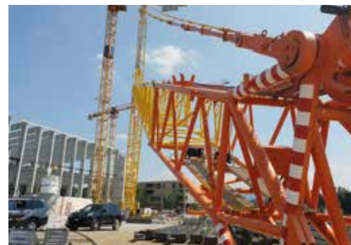
Äusserste Präzision und schweres Geschütz beim Aufbau des Stahlgebäudes
