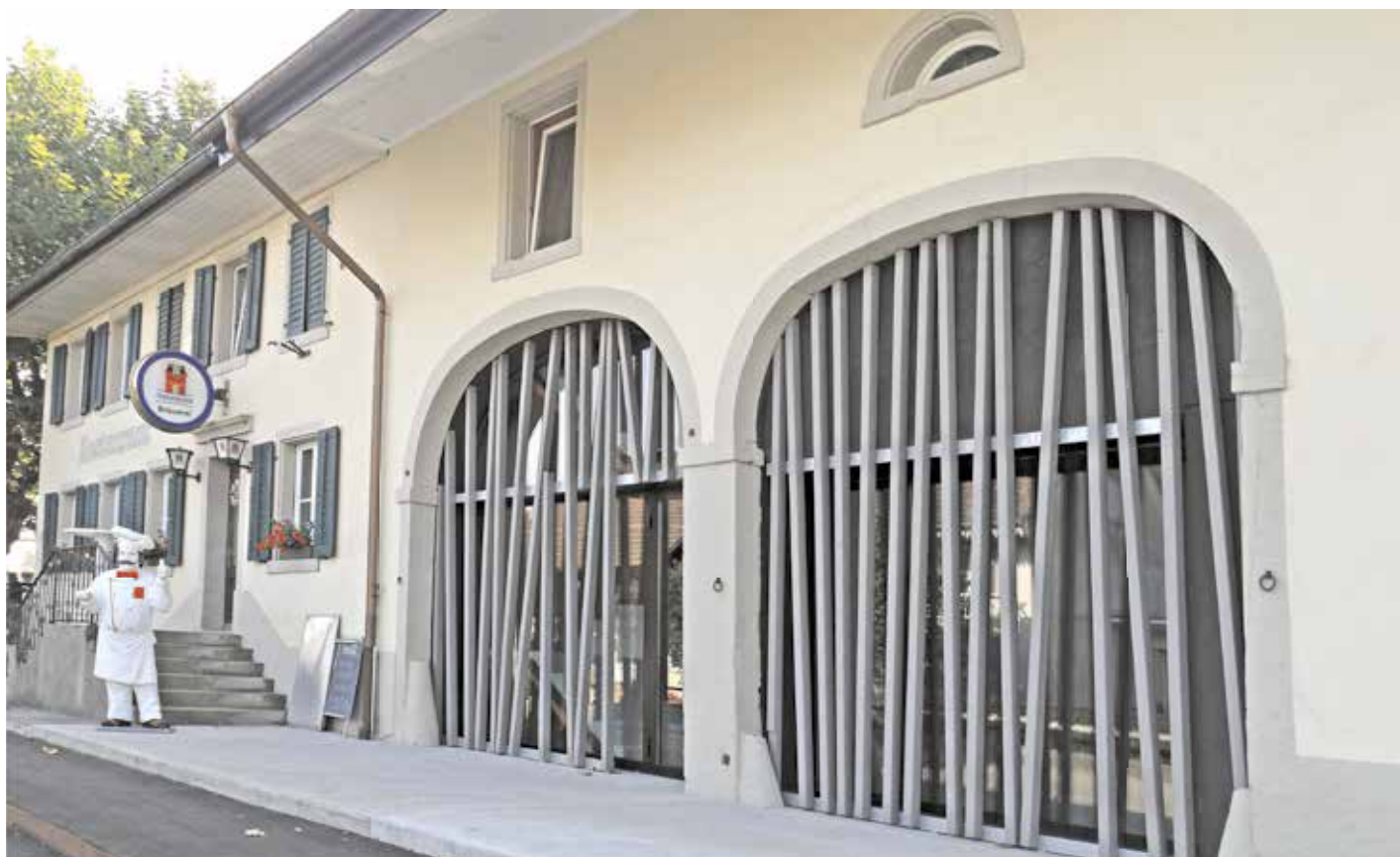
Umbau Braui, Mägenwil: Komplettsanierung Holzbauarbeiten
