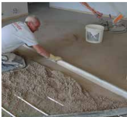
Zementestrich mit Bodenheizung
