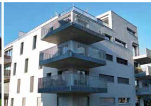
Staketebalkongeländer mit speziellem Anschlussdetail sowie Glasbalkongeländer mit verchromtem Handlauf
