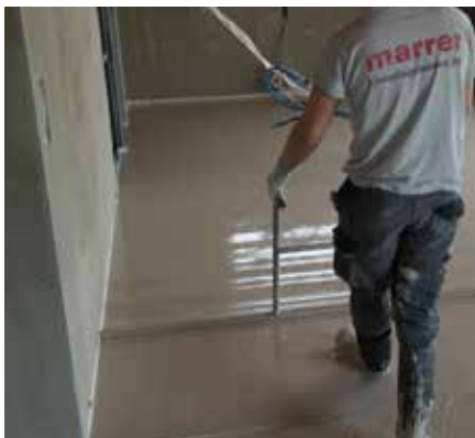
Einbringen von Fliessestrich
