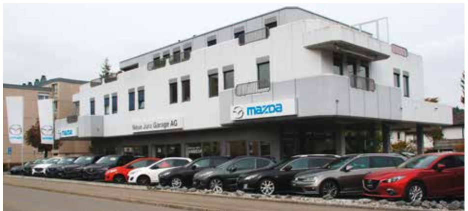
In Mellingen, an der Aargauerstrasse 5, bietet die NJG einen grossen Showroom und eine entsprechend grosse Palette an Mazda-Neufahrzeugen und -Occasionen.
