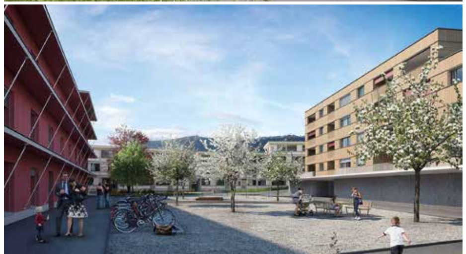
Der gemeinsame Vorplatz bildet das verbindende Element aller Wohnbauten und ist für die Belebung der «Oberstadt» von grosser Bedeutung. Grosszügige Terrassen und Loggias tragen der besonderen Umgebungsqualität Rechnung.
