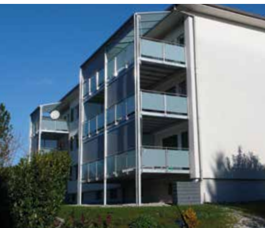
Vorgehängte Balkone, Glasgeländer, Bedachungen und Beschattungen
