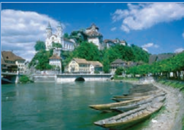
Aarburg, Festungsanlage mit Kirche
