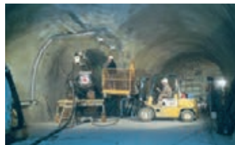
Arbeiten im Opalinuston des Felslabors Mont Terri
