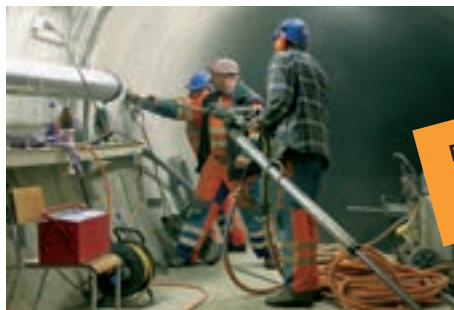
Vorarbeiten für das Ausgraben einer Versuchszone.
