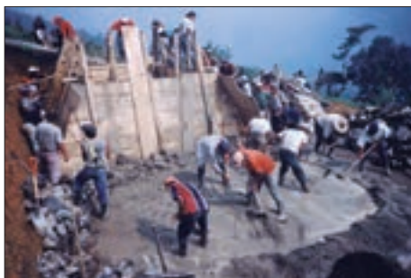
Baustelle Reservoir La Libertad
