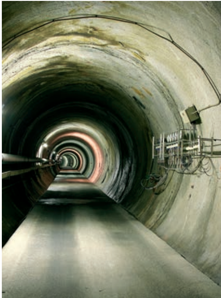
Stollen im Felslabor Grimsel mit Messapparatur
