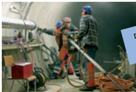
Vorarbeiten für das Ausgraben einer Versuchszone.
