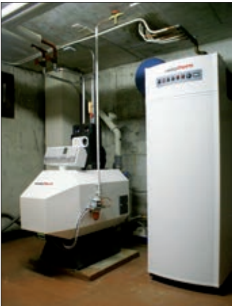
Beispiel einer Öl-Kondensationsanlage (Brennwert) mit WP-Boiler
