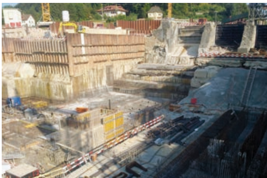
Anspruchsvolle Aushubarbeiten beim Kraftwerk Hagneck
