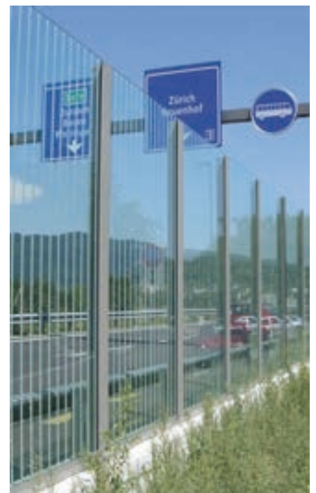
Grosses aktuelles Thema – Lärmschutz an der A1 bei Neuenhof
