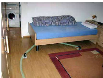
Dämmschicht Trocknung mit Boden Stützen
