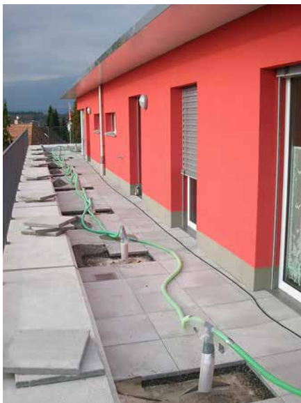
Trocknung auf einem Flachdach
