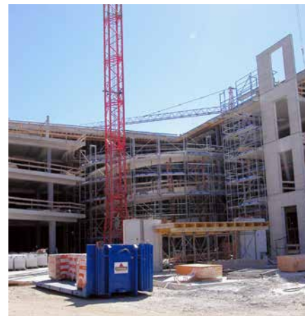
Bauen für das Gewerbe: Hier erstellt die A. Soltermann AG, Unterkulm, eine spezielle Garagenauffahrt für das Ausstellungsgebäude von Möbel Hubacher.
