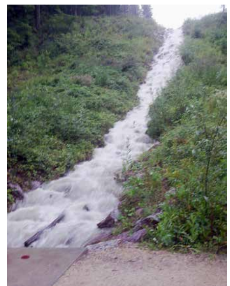
Blockstufe einer durch die Senn-Ingenieure und -Planer renaturierten Bachkorrektur im Auftrag einer Aargauer Gemeinde
