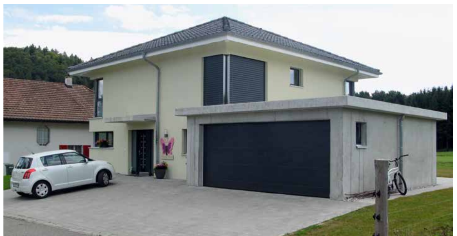
Einfamilienhaus in Hunzenschwil, Baujahr 2013
