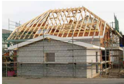
Holzbau – Ein Fall für die Blattners: Die gesamte Holzkonstruktion mit Balkenlage, Hauptdach mit Lukarne und Garagendach sowie der Innenausbau mit Wärmedämmung kommt aus einer Hand.
