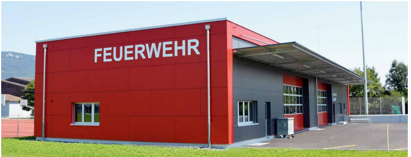
Fassadenbau – Die Fassadenverkleidung mit Holzunterkonstruktion, Aussenisolation und sichtbarer Kunstharzplattenverkleidung am neuen Feuerwehrgebäude im solothurnischen Neuendorf, wurde von der Hans Blattner AG erstellt.
