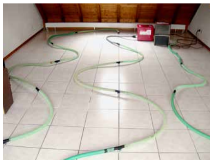
Dämmschicht Trocknung über die Fugenkreuze
