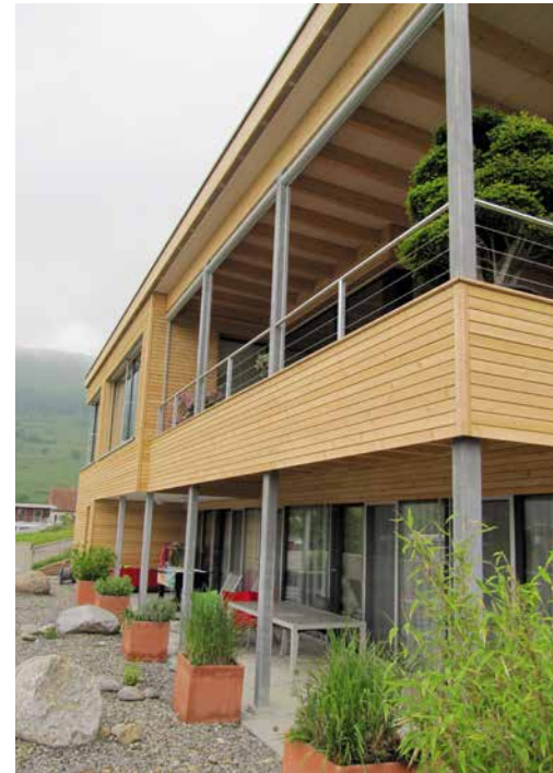
«Wir glauben an die Zukunft des modernen Holzbaus», lautet die Devise des Holzbau-Unternehmens Hans Blattner AG. Hier ein Einfamilienhaus in Küttigen.
