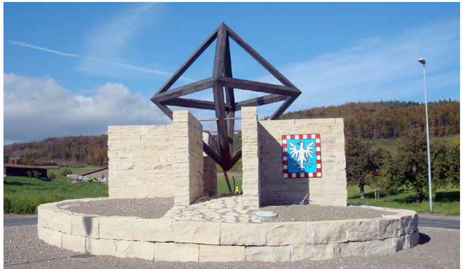
Verkehrsanlagen wie dieser Kreisel bei Tegerfelden gehören ebenso zum Portfolio der Ingenieurbüro Senn AG, wie öffentliche und private Siedlungsplanung sowie Versorgungs- und Entsorgungssysteme.
