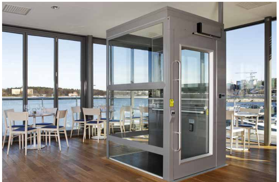
Personenaufzug, ohne separaten Schacht, montiert in Deckendurchbruch
