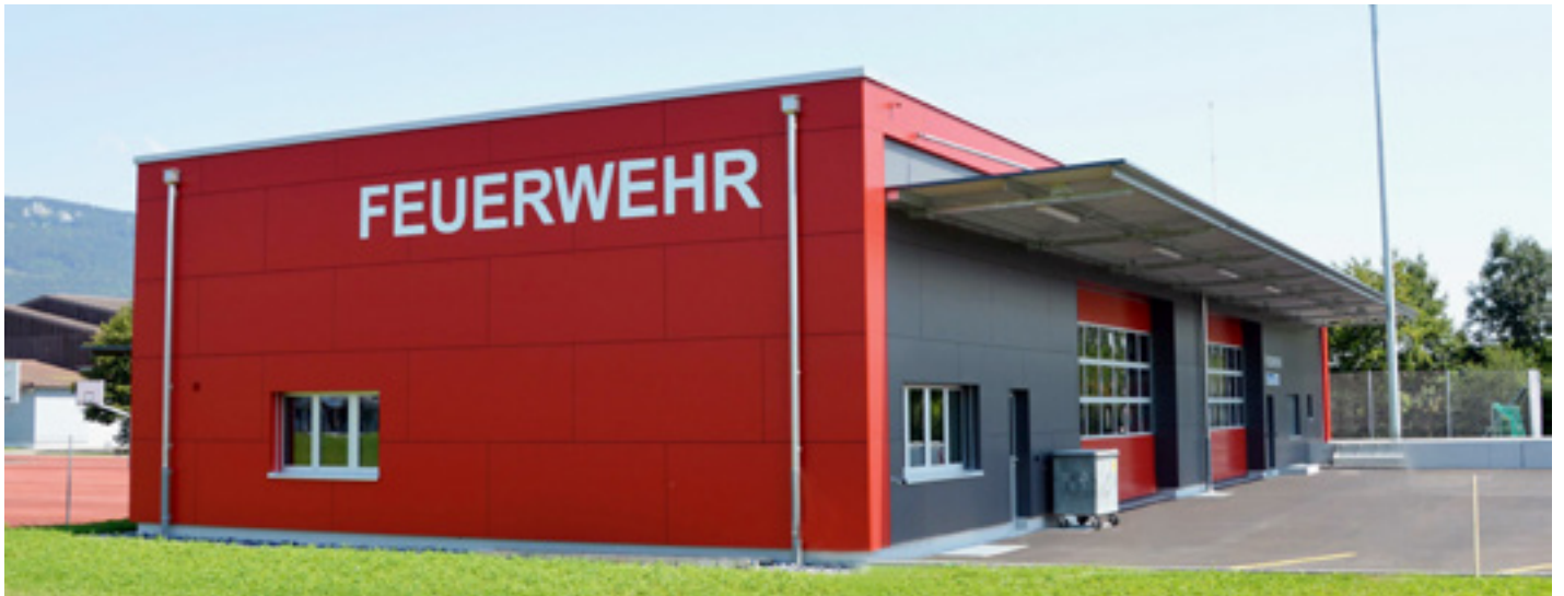
Fassadenbau – Die Fassadenverkleidung mit Holzunterkonstruktion, Aussenisolation und sichtbarer Kunstharzplattenverkleidung am neuen Feuerwehrgebäude im solothurnischen Neuendorf, wurde von der Hans Blattner AG erstellt.
