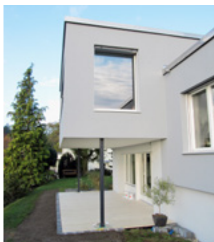
An- und Umbauten – Bei diesem Objekt in Rombach wurde ein alter Betonbalkon demontiert und das bestehende Zimmer vergrössert. Unter dem Anbau ist Platz für einen gemütlichen Sitzplatz.
