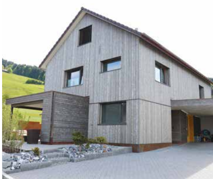
Einfamilienhaus mit vorvergrauter Holzschalung
