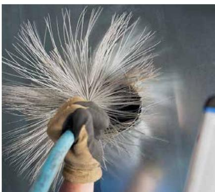
Flexible Welle : Es gibt verschiedene Reinigungssysteme, Bürsten- und Microfaserwellensystem, wie auch Nassreinigung/Chemie oder Luftdruck.
