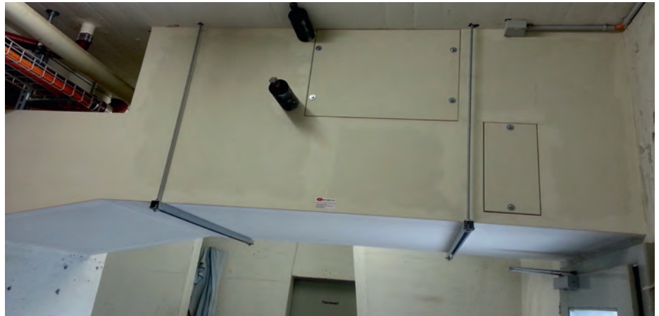
Verkleidung eines Lüftungskanals mit Promat und Revisionsdeckel.
