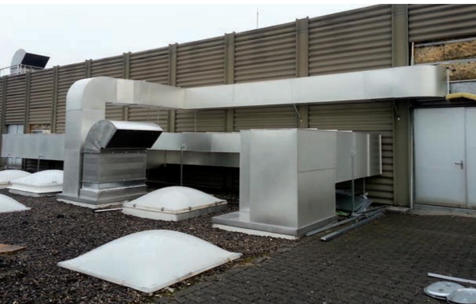
Thermische Dämmung eines Lüftungskanal mit Alublechummantelung
