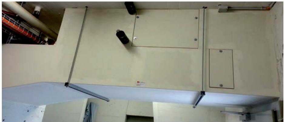
Verkleidung eines Lüftungskanals mit Promat und Revisionsdeckel
