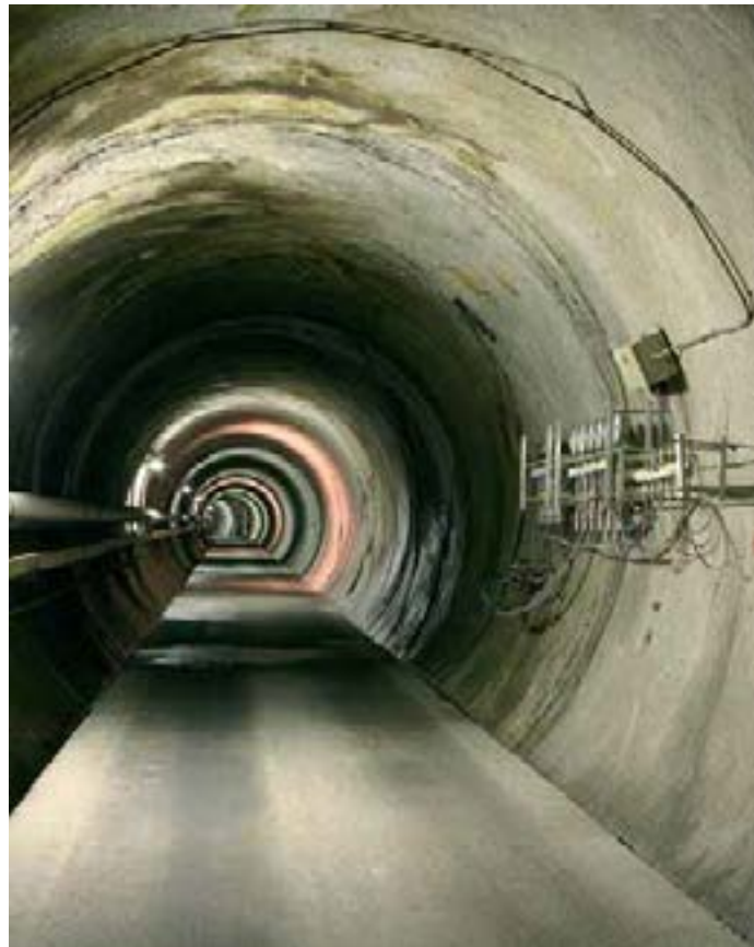
Stollen im Felslabor Grimsel mit Messapparatur.
