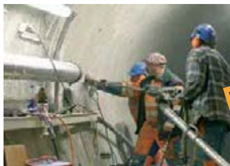
Vorarbeiten für das Ausgraben einer Versuchszone.
