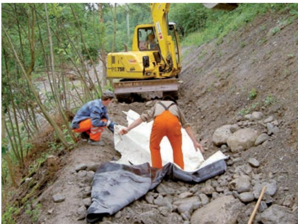
*Bachlauf auf der Berme, wo eine Abdichtung mit Vlies und Folien erfolgte*
