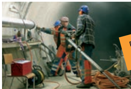
Vorarbeiten für das Ausgraben einer Versuchszone.
