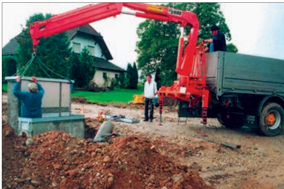
Das Versetzen der Kabinen erfolgt mit dem eigenen Lastwagenkran.
