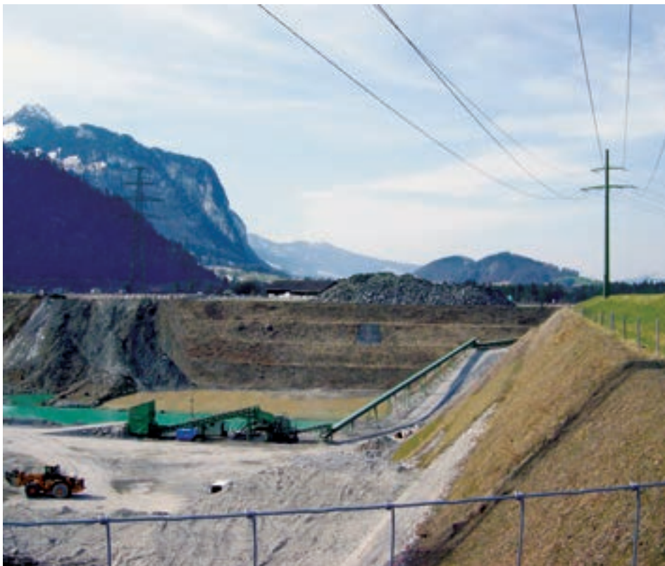
Bachlauf auf der Berme, wo eine Abdichtung mit Vlies und Folien erfolgte.
