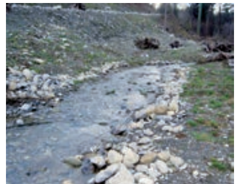
Im oberen Teil mit Trockenmauern und offener Struktur kann sich die Vegetation noch entwickeln.
