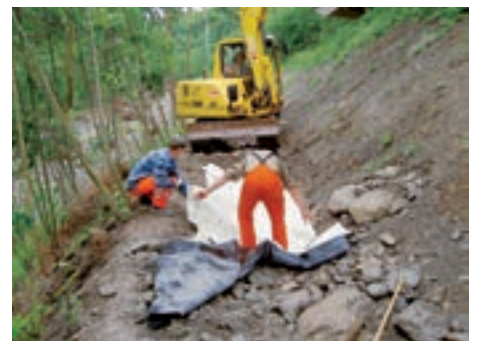
Bachlauf auf der Berme, wo eine Abdichtung mit Vlies und Folien erfolgte.
