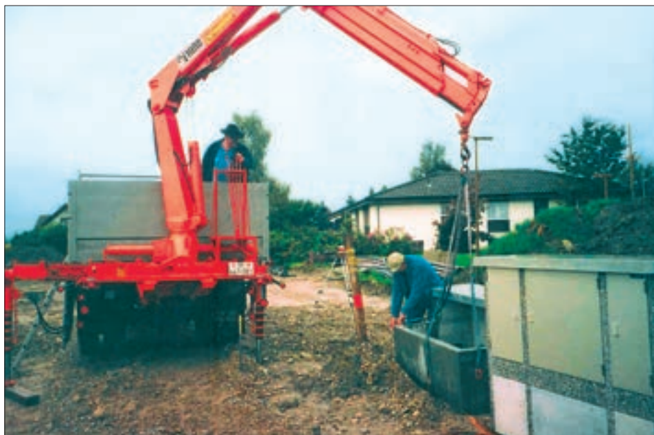
Das Versetzen der Kabinen erfolgt mit dem eigenen Lastwagenkran.
