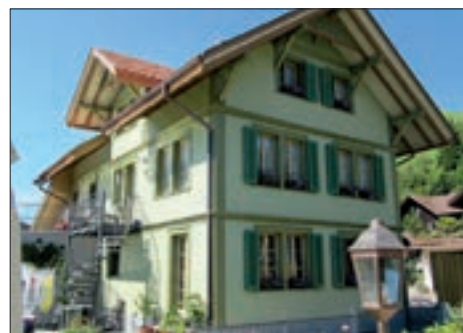
Fassadensanierung EFH, Langnau
