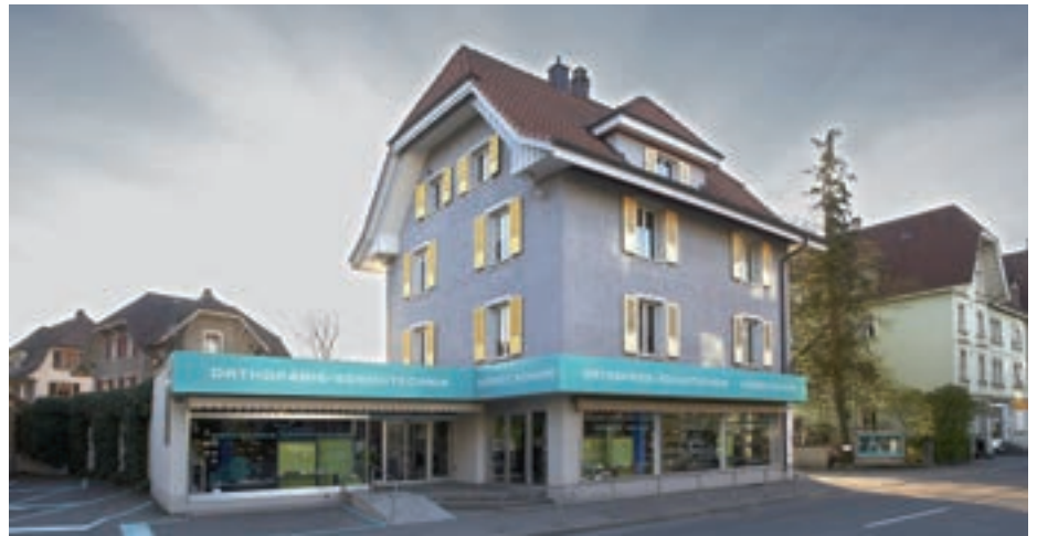
Das Schuh- und Fuss- Kompetenzzentrum Hermes an der Bielstrasse 21 in Lyss
