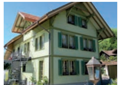
Fassadensanierung EFH, Langnau
