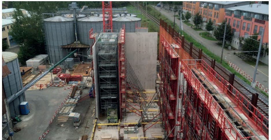
Erweiterung des Getreidesilos der Landi Zola in Illnau (ZH)
