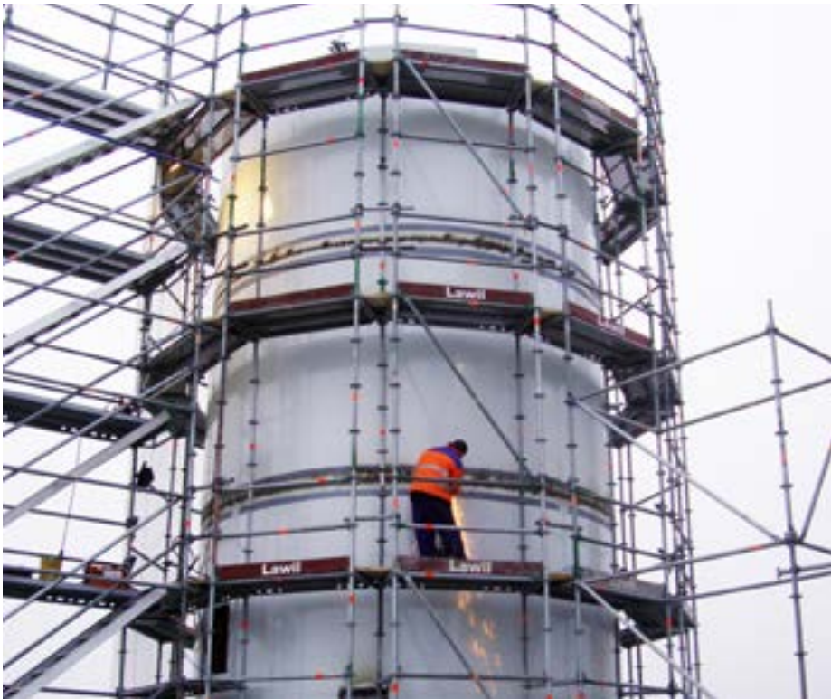
Montage der platzgeschweissten Trockenschlacken-Silos auf dem Dach der Innenaufbereitung (Metallrückgewinnung) der KEZO Hinwil
