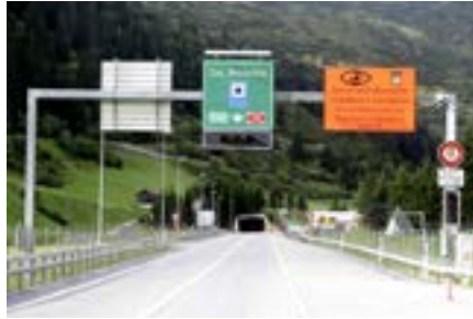
Tunnelleinfahrt San Bernardino Nord in Richtung Tessin. (Bild: Adrian Michael)
