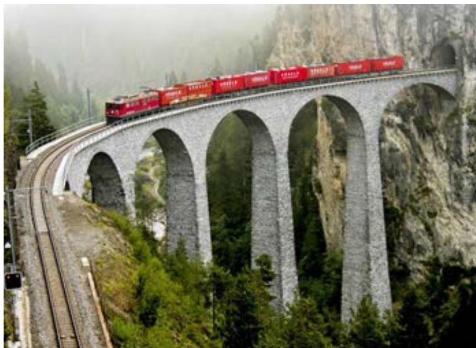
Transportlogistik auf dem Schienenweg am Landwasserviadukt.
