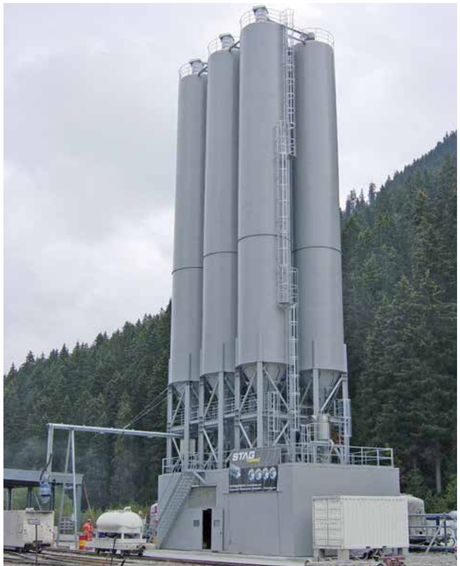
Über spezielle Förderrohrleitungen mit Dichstromprinzip wird Schüttgut 1100m weit gefördert.
