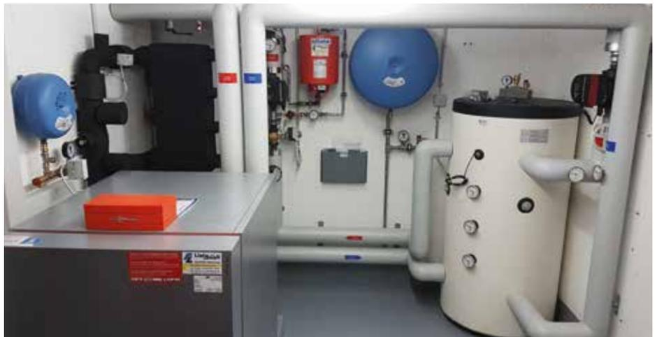
Sanierung mit Wasser- Wasserwärmepumpe 35 kW mit FU regulierter Grundwasserpumpe. (3 Heizungen sind daran angeschlossen)
