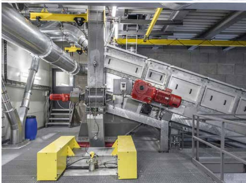
Staubdichte, mechanische Förderung von Trocken-Schlacke
