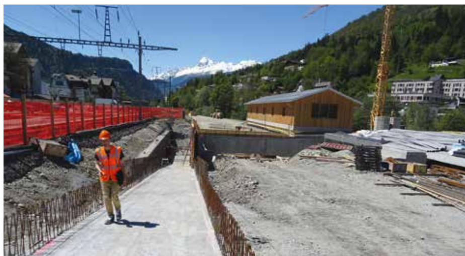
Der Ausbau des Bahnhofes Illanz ist aktuell eines der wichtigsten Projekte der Rhätischen Bahn (RhB). Hier tritt die F. Preisig AG sowohl als Projektplanerin als auch als Bauleiterin auf.
