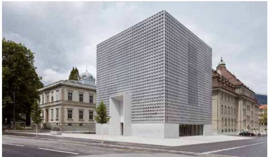
Erweiterungsbau Bündner Kunstmuseum mit Anbindung an die bestehende Villa Planta, enge Zusammenarbeit mit Lichtplaner, Intrusionsschutzplaner sowie MSRL-Planer, Foto: Ralph Feiner
