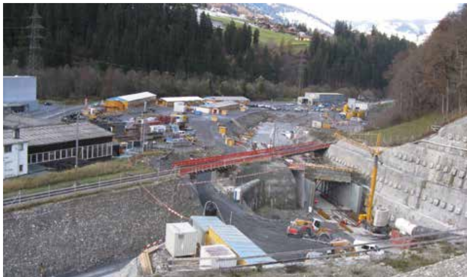
Beim Grossprojekt Umfahrung Küblis hatte die F. Preisig AG die Projektleitung inne. Das 210 Millionen-Franken-Projekt konnte im vergangenen Jahr eröffnet werden.
