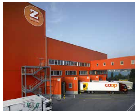
Die Fabrikation der Zweifel Chips in Spreitenbach – auch hier sind Fenster und Türen von WOSTRAG eingesetzt.
