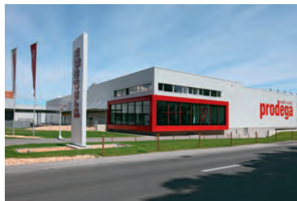
Türen und Fenster der WOSTRAG Metallbau findet man an Referenzobjekten in der ganzen Schweiz: Hier bei Prodega in St-Blaise.
