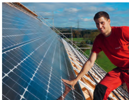
Dachsanierung mit Photovoltaik.
