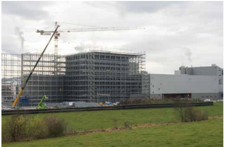
In Sulgen haben die Hitzkircher Spezialisten ein automatisches Paletten-Hochregal von fast 32 Metern Höhe errichtet – von A bis Z.
