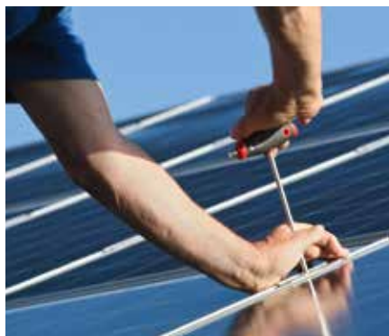
Die fachgerechte Montage der Solarpanels
