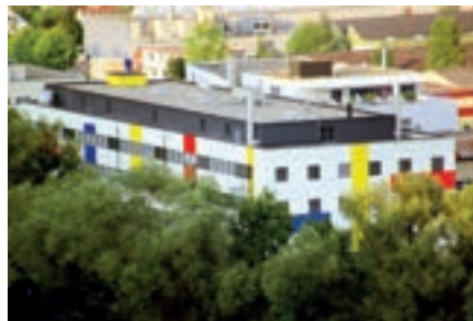
Bachem AG, Industrie-Neubau
