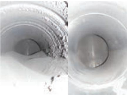
Rauchrohr vor der Reinigung nach der Reinigung
