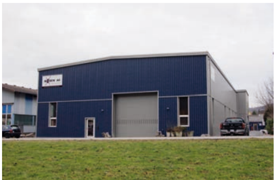
für kpl. Dach und Wandverkleidungen (Neubau Werkhalle Ridem AG Bubendorf)
