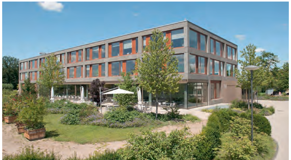
Bürogebäude Bürgerspital Basel heute
