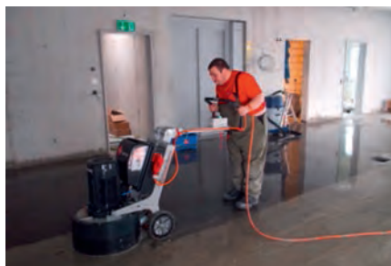
Bodenschleifarbeiten / Terrazzo
