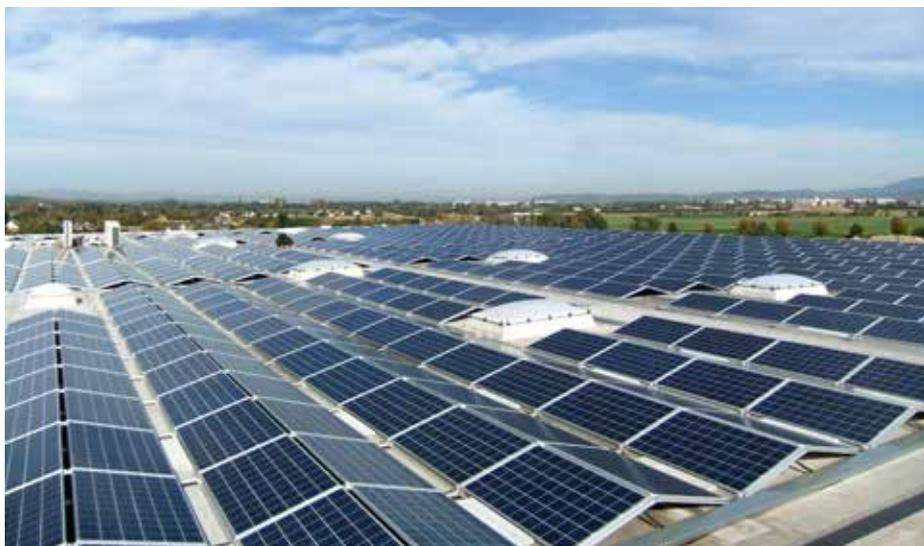
Allein über dieses Dach in Allschwil mit 3575 Quadratmetern Fläche und 1518 Modulen speist PrimeEnergy 390 Megawatt (MW) pro Jahr ins Netz ein.
