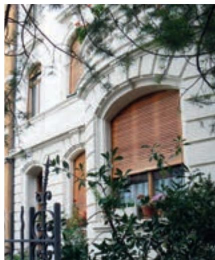
Schweizergasse, Basel: Figura Holzrolläden mit eingefrästen Lichtschlitzen
