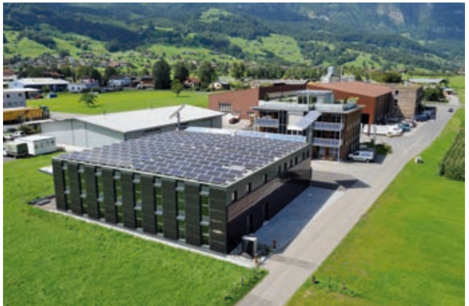
Solarpark und Synergiepark, Gams SG
