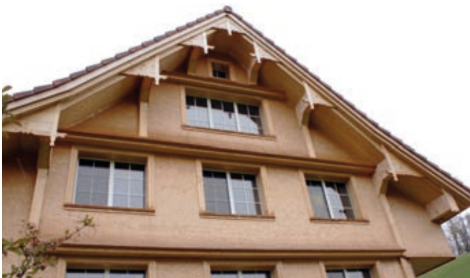
Bauernhaus, vermutlich aus dem 18. Jahrhundert, komplett saniert
