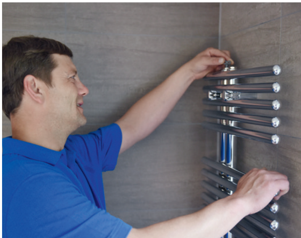
Inbetriebnahme eines Handtuchheizkörpers.
