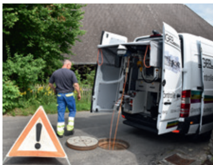
Mit dem Kanalfernsehen werden die Leitungen kontrolliert.
