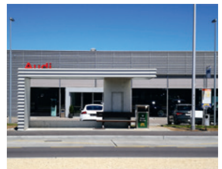
Neubau Bushaltestelle in Zuchwil
