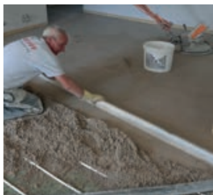
Zementestrich mit Bodenheizung
