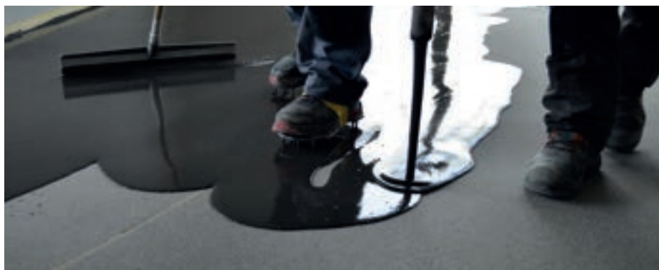
Mineralischer Spachtel-Designboden wird auf Zementuntergrund gegossen.
