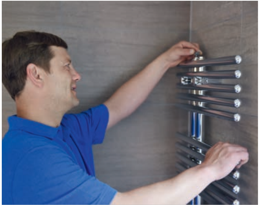
Inbetriebnahme eines Handtuchheizkörpers
