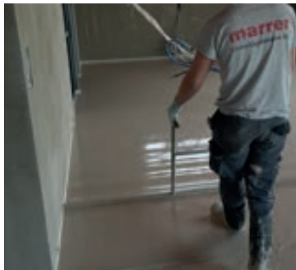
Einbringen von Fliessestrich
