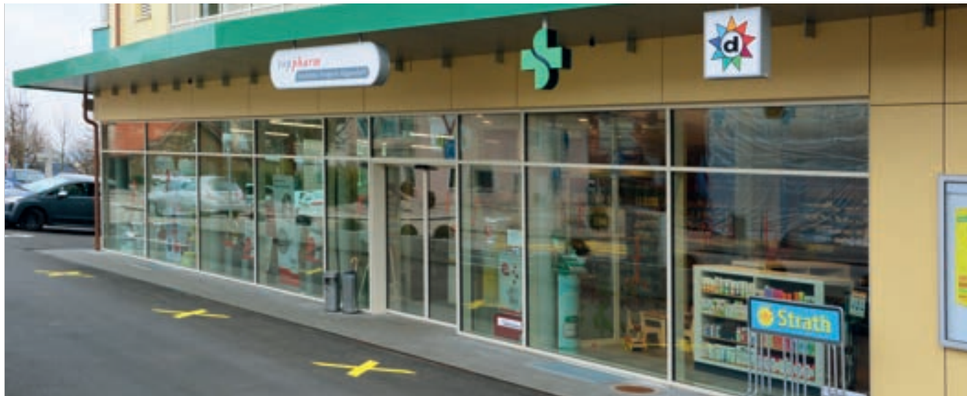
Mitte Oktober 2017 wurde die neu gebaute Apotheke Drogerie Hägendorf eröffnet.
