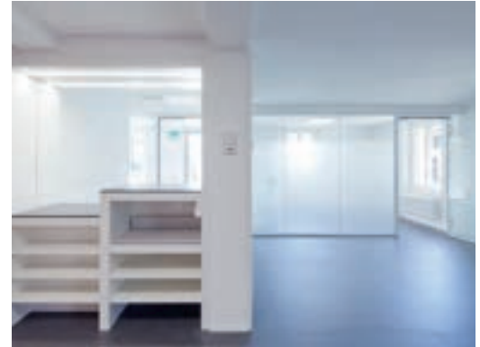
Umbau und Sanierung Verwaltungsgebäude in Rechterswil
