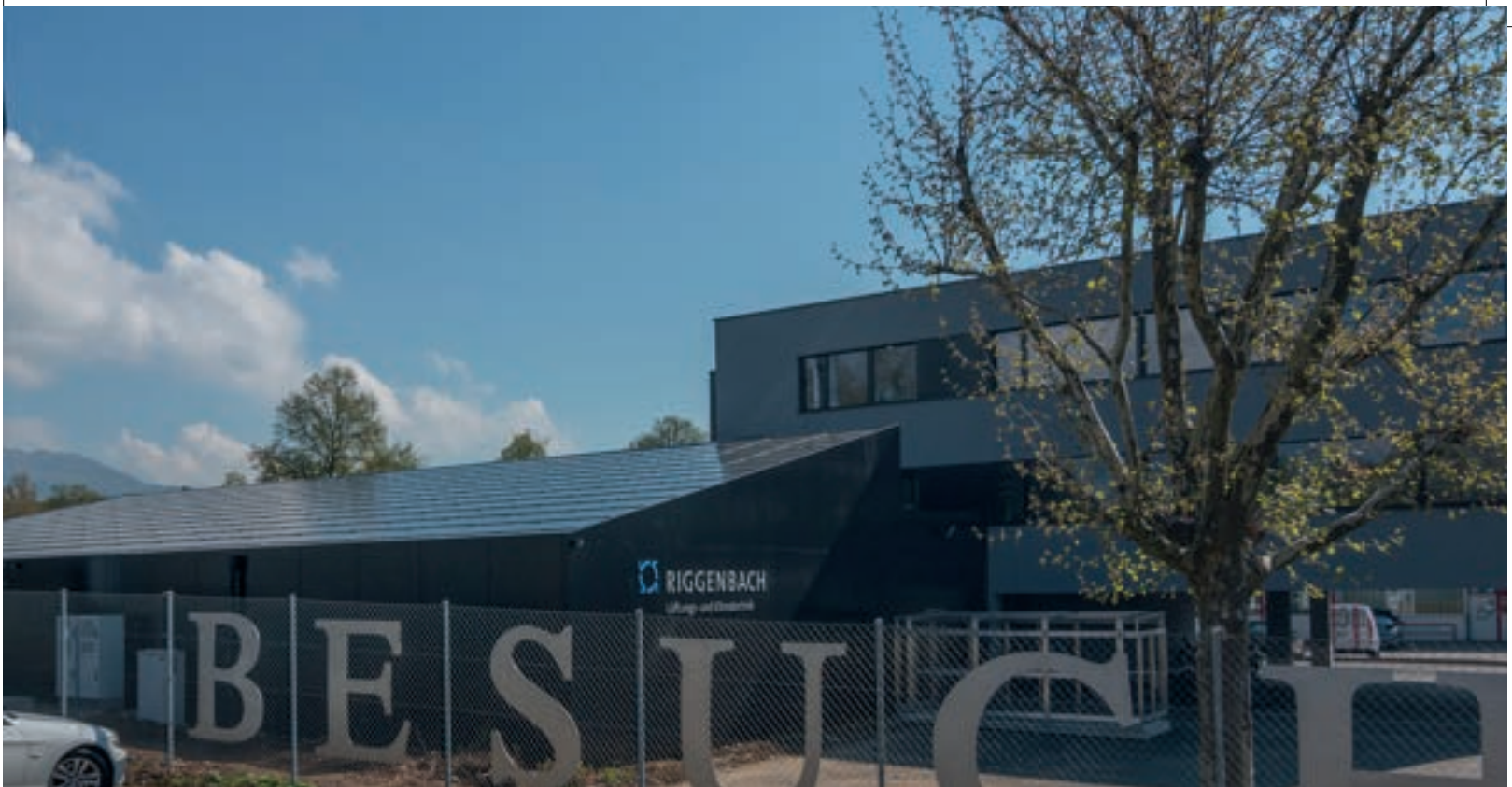
Solaranlage à la von Arx bei der Firma Riggerbach
