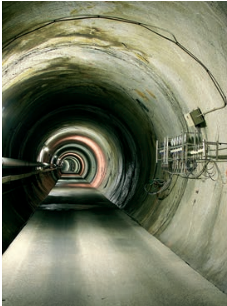
Stollen im Felslabor Grimsel mit Messapparatur
