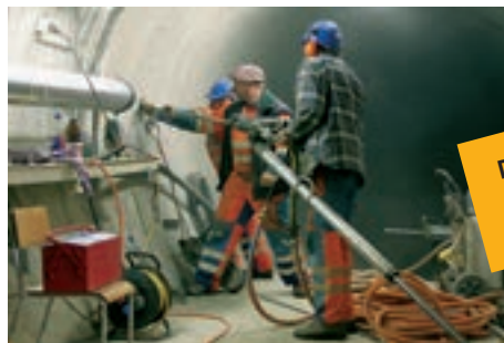
Vorarbeiten für das Ausgraben einer Versuchszone.
