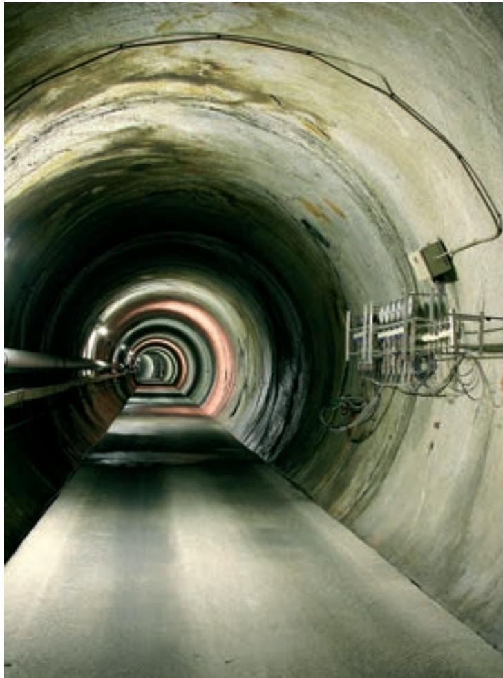
Stollen im Felslabor Grimsel mit Messapparatur
