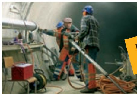
Vorarbeiten für das Ausgraben einer Versuchszone.
