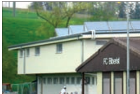
Elementaufstockung FC Biberist 2007
