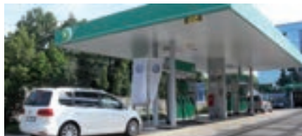
Standort Solothurn mit moderner Tankstelle und Waschanlage.
