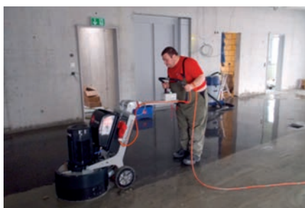
Bodenschleifarbeiten / Terrazzo
