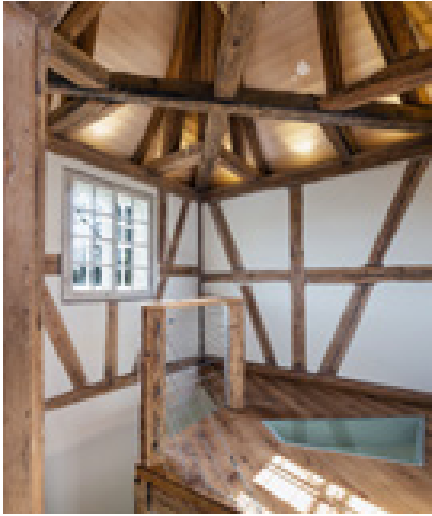
Dachstock im Türmli Eintritt in die Wohnung (Foto von der Denkmalpflege Solothurn)
