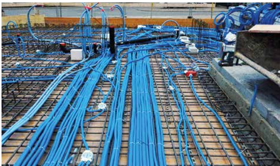
Einlegearbeiten bei MFH-Neubau (oben).
