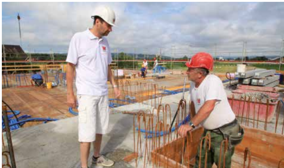
Auf der Baustelle eines Neubaus: Bauunternehmer Rico Wanzenried im Gespräch mit einem Mitarbeiter.
