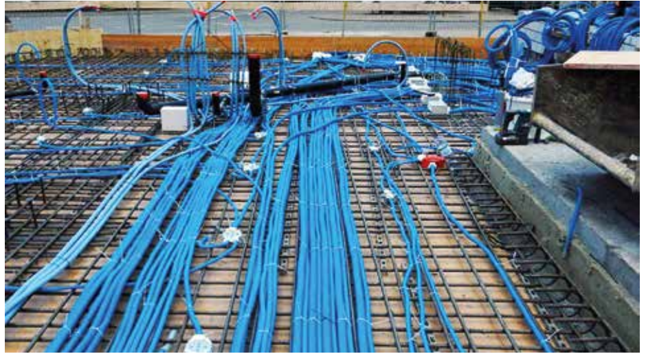
Einlegearbeiten bei MFH-Neubau (oben)
