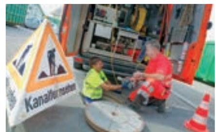
Kanal-TV: Die Leitungen werden mit Kanalfernsehen am Einsatzort überprüft.
