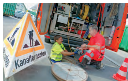
Kanal-TV: Die Leitungen werden mit Kanalfernsehen am Einsatzort überprüft.
