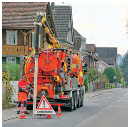
Entleeren von Strassenschächten.
