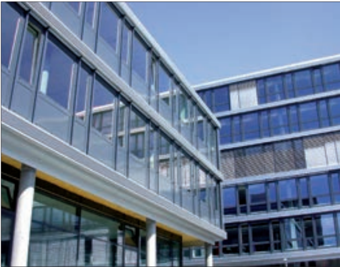
Standort der Regimo Zug AG im Areal Kistenfabrik Zug
