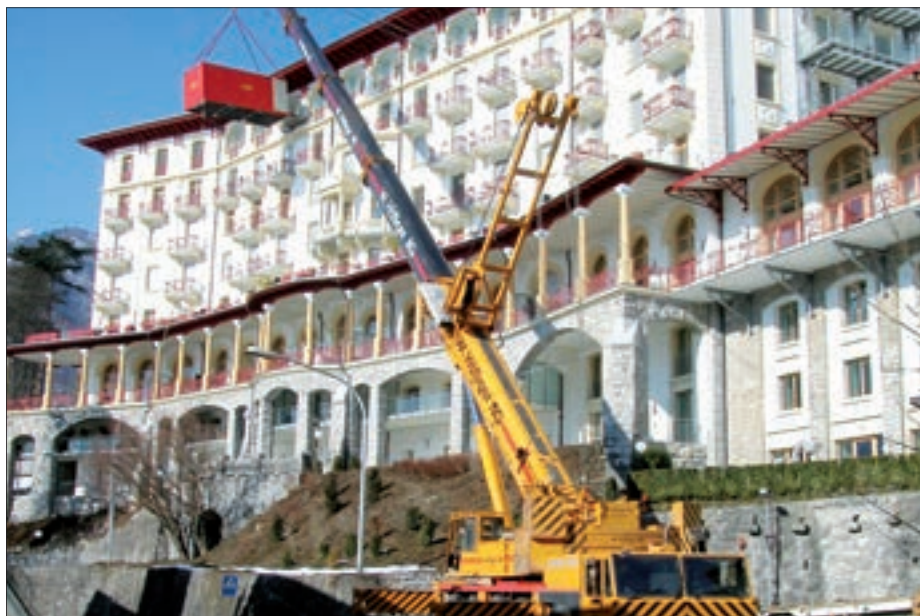
Umzug mit Pneukran und Container in Brunnen, Grand Palais
