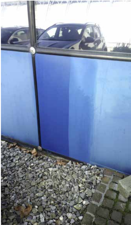
Fassaden werden von den Reinigungs-Profis aus Cham auch versiegelt. Im Bild ist die dunkle Fläche versiegelt, links daneben die gereinigte und weiter links die ungereinigte Fläche.
