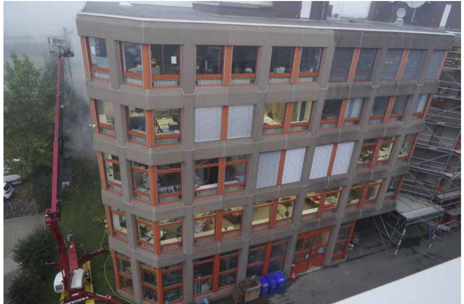
Die Reinigung von Fassaden und Fenstern gehören ebenfalls zum Leistungsportfolio der perlen reinigungen zug.
