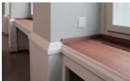
Neue Simse in Eiche mit umlaufendem Kranzprofil.
