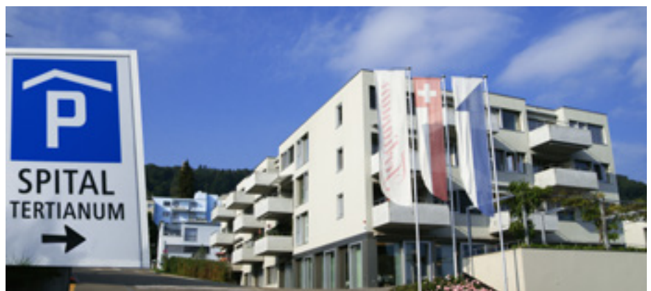
...und ebenso im Tertianum des Spitals Horgen, an der Asylstrasse 18.
