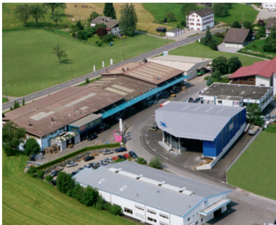
In Samstagern, keine zwei Minuten von der Autobahnausfahrt Richterswil entfernt gelegen, findet sich im Industriequartier an der Tambourstrasse 6 die Verzinkerei Wollerau AG.
