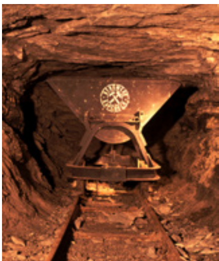
Bild einer Lore, eines Kipptransporters auf Schienen, der im Bergwerk Käpfnach zum Transport der Kohle und des Schuttes auf die Deponie gebraucht wurde.
