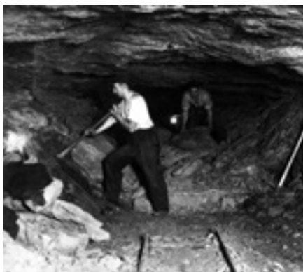
Originalfoto aus der Abbauperiode 1941–1947. Zwei Arbeiter beim Räumen eines alten Stollens.
