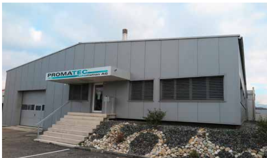
Das Bürogebäude der Promatec Automation AG in Derendingen
