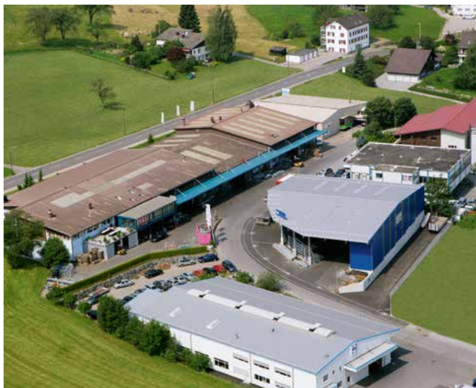
In Samstagen, keine zwei Minuten von der Autobahnausfahrt Richterswil entfernt gelegen, findet sich im Industriequartier an der Tambourstrasse 6 die Verzinkerei Wollerau AG.
