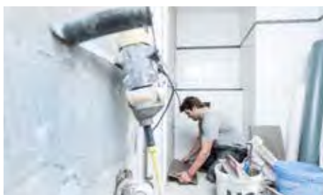
Abdichtung im Bad ist Millimeterarbeit.
