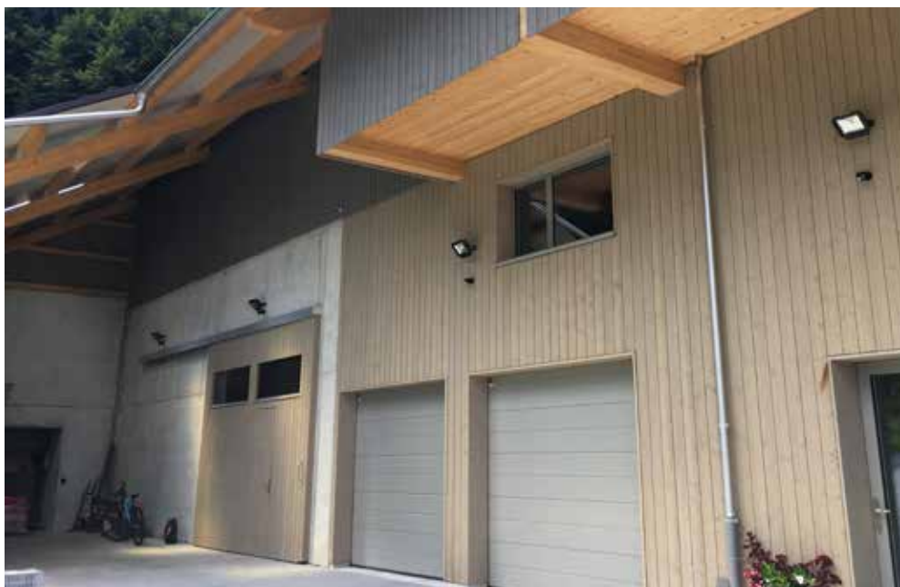
Die neue Produktionshalle wird ausschliesslich mit Holz aus dem Napfbergland gebaut.
