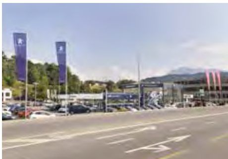
Standort Luzern-Littau Garage Galliker
