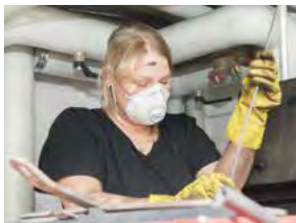
Reinigung einer Pelletsfeuerungsanlage.
