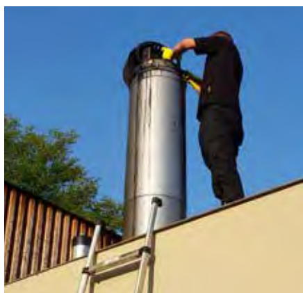
Hoch hinaus bei der Reinigung eines Kamins.
